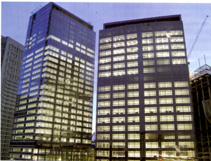
Para garantir a eficiência energética durante a operação, instalações são monitoradas por um sistema de supervisão predial computadorizado
