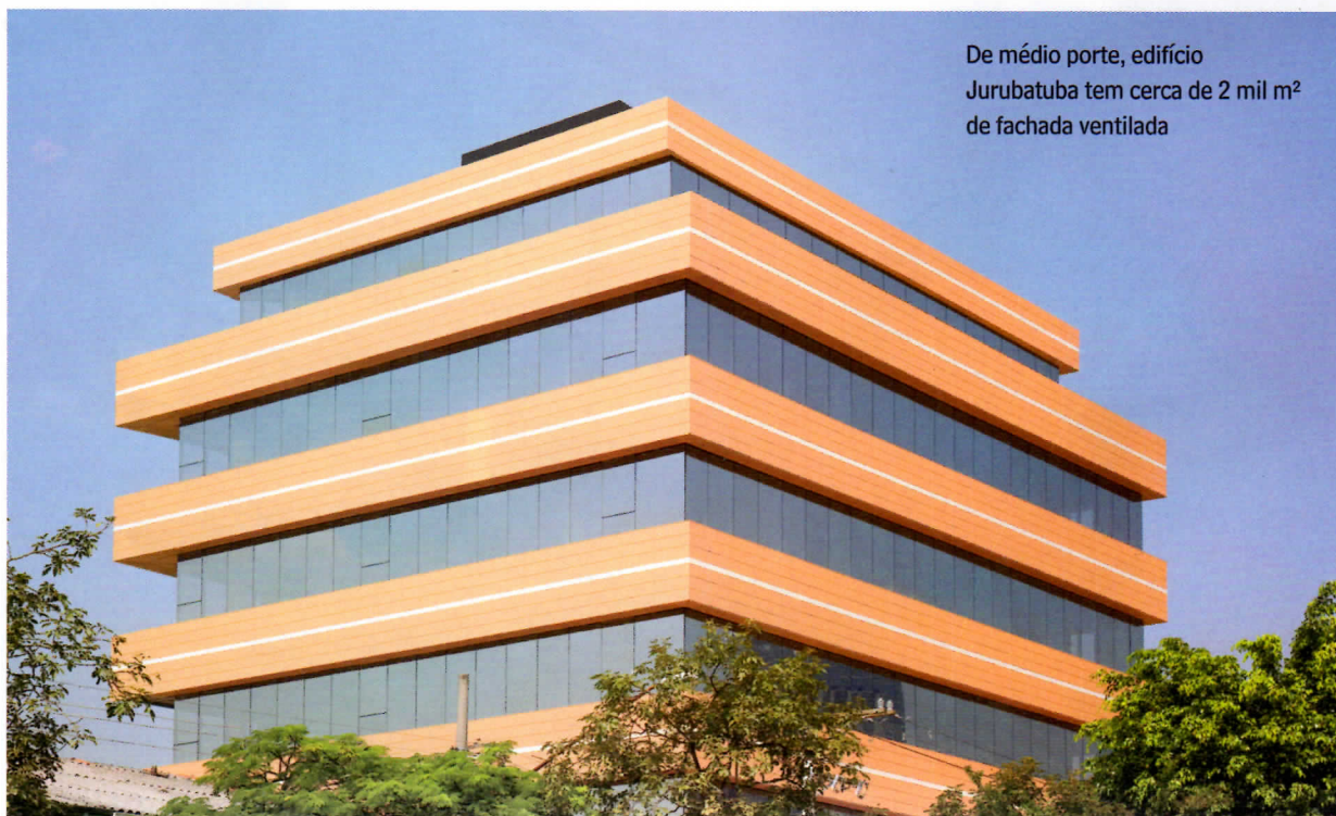
Fachada ventilada também reveste a parte de cima do edifício
