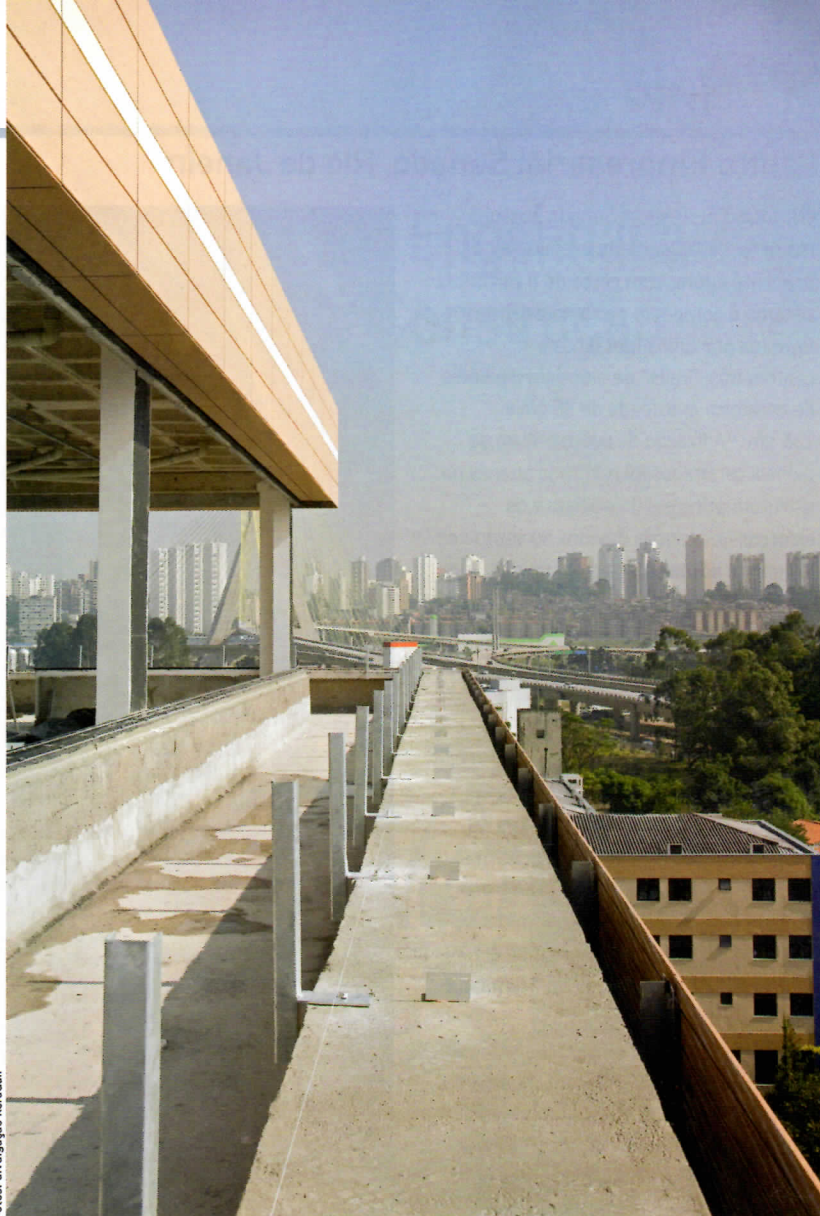
Fachada ventilada também reveste a parte de cima do edifício
