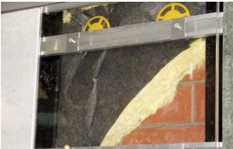
Fachada de porcelanato com proteção de fibra de vidro, na Itália
