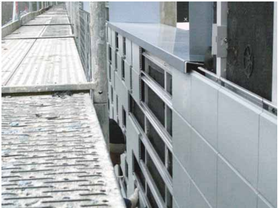
Colocação da peça cerâmica extrudada na subestrutura em obra na Alemanha
