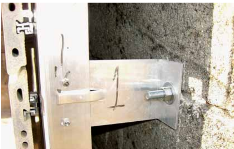
Encaixes na peça extrudada facilitam a montagem. O espaço entre os dois paramentos funciona como uma câmara de circulação e renovação de ar
