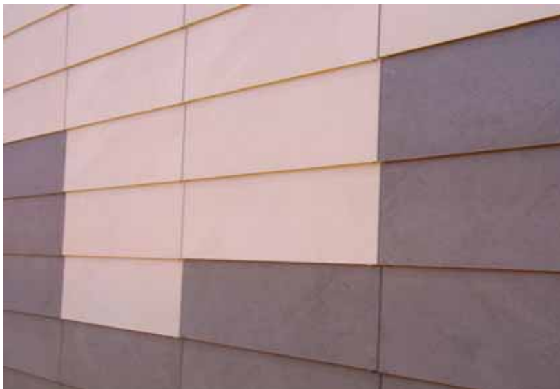
Porcelanato com ancoragem aparente fachada de prédio na Espanha
